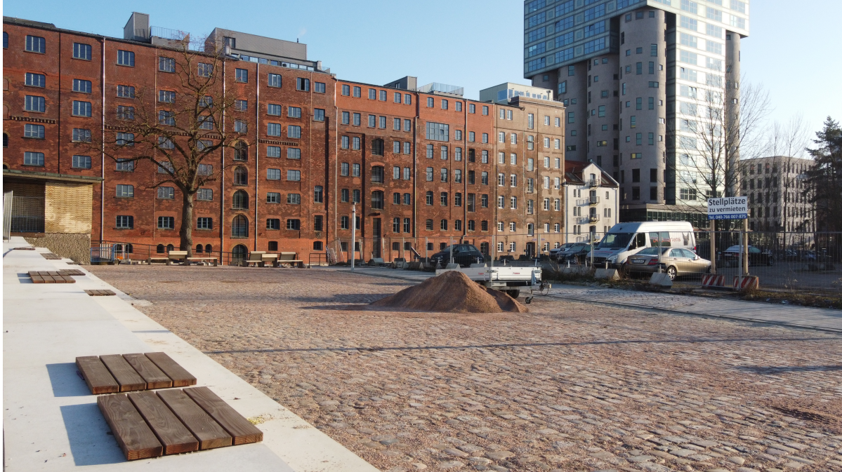
Bild: steg Hamburg, letzte Bauarbeiten laufen am südlichen Kanalplatz
